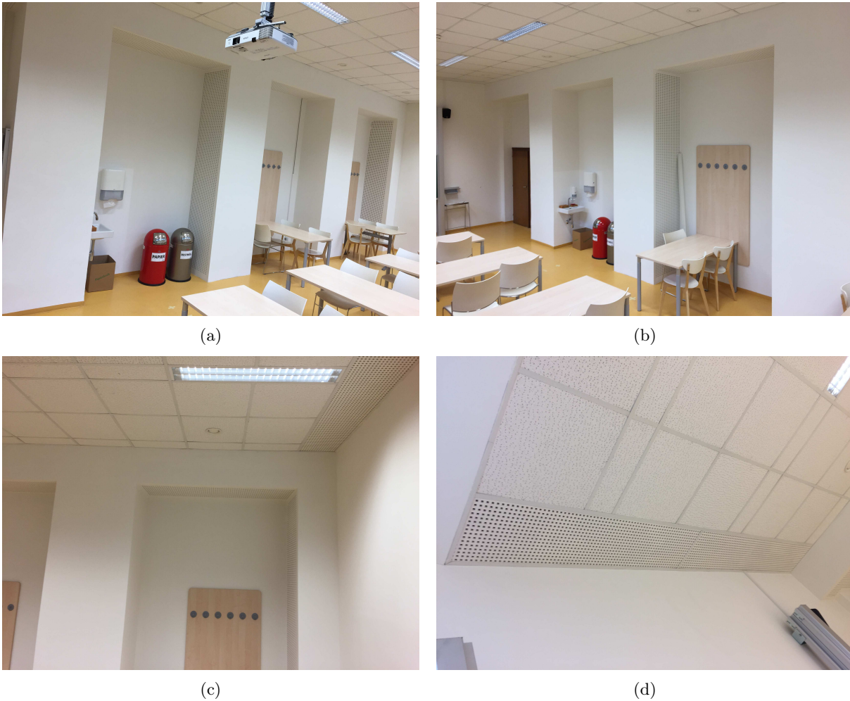
Abbildung 6.5: Fotos des Hörsaals i15 nach der Sanierung
