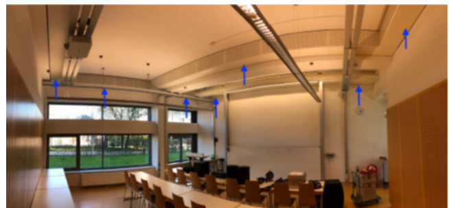
Abbildung 9: Hörsaal FSI2 nach der akustischen Sanierung mit den eingebauten KA an der Decke.
