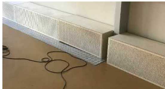
(d) Erfüllen der Anforderungen von räumlichen Strukturen durch Kombination der Module und Abschlussplatten.
