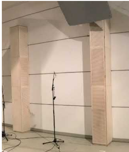
(a) Kantenabsorberraufstellung mit zwei schmalen Türmen in der Fläche der Raumlängsseite. Es wurde jeweils eine zusätzliche Außenwand aufgeschraubt.
