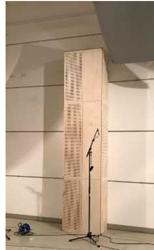
(b) Kantenabsorberraufstellung mit einem breiten Turm in der Fläche der Raumlängsseite.
