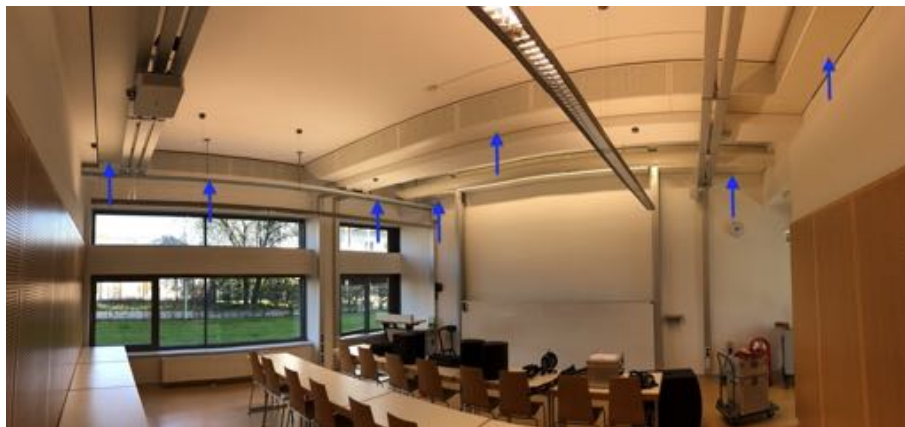
(c) Panoramaaufnahme des HS FSI2. Blaue Pfeile markieren Bereiche mit Kantenabsorbern.
