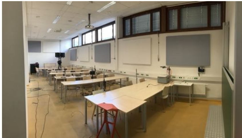
Abbildung 3.12: Hörsaal i14 an der TU Graz. An den Wänden wurden akustische Wandelemente angebracht.
