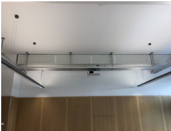
(a) Einbau Kantenabsorber an hinterer Wand.
