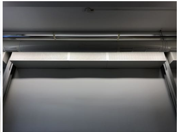
(b) Einbau Kantenabsorber im Bereich der Tafel.
