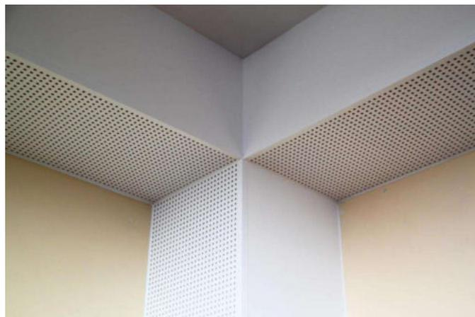
**Abbildung 2.2:** Kantenabsorber in Trockenbauweise [Jäcker-Cüppers 2015]
