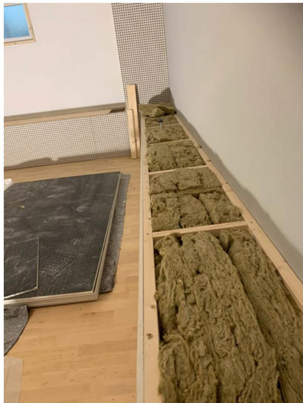
Abbildung 60: Mineralwolleplatten werden in die Unterkonstruktion mit leichtem Druck eingepasst.
