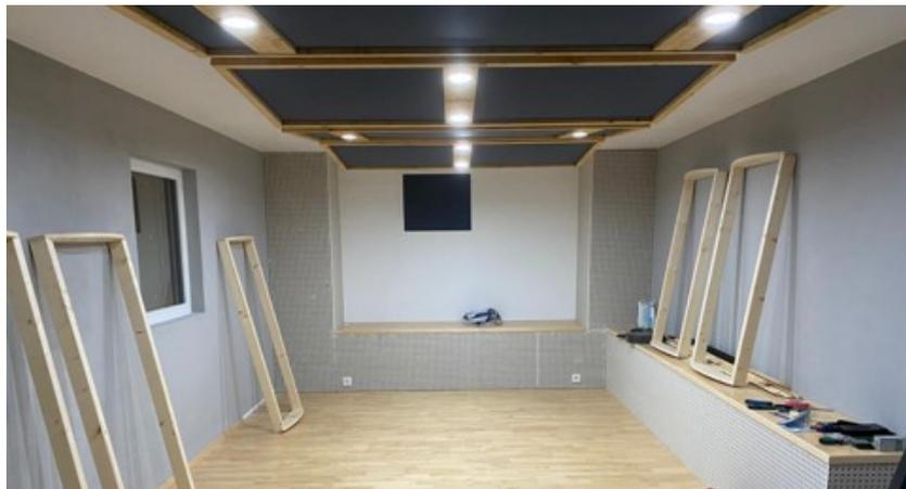
Abbildung 63: Eingebaute Deckenkonstruktion, Vorbereitung der Wandelemente.
