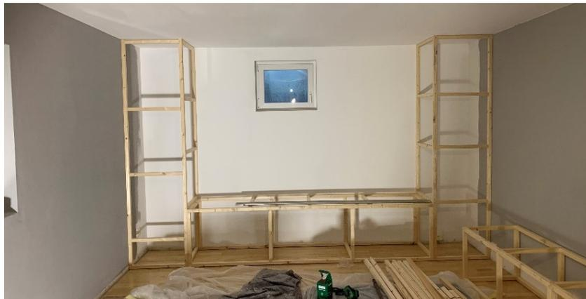
Abbildung 59: Rahmenkonstruktion aus Holz für den Kantenabsorber
