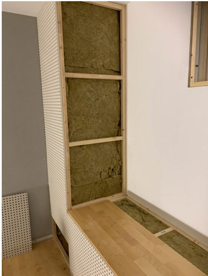
Abbildung 61: Die Abdeckung mit Parkettelementen soll später einige Ablageflächen ermöglichen
