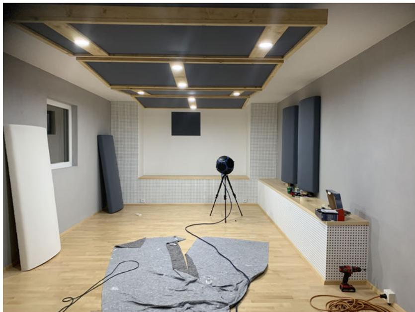
Abbildung 65: Regieraum nach Einbau der Absorber
