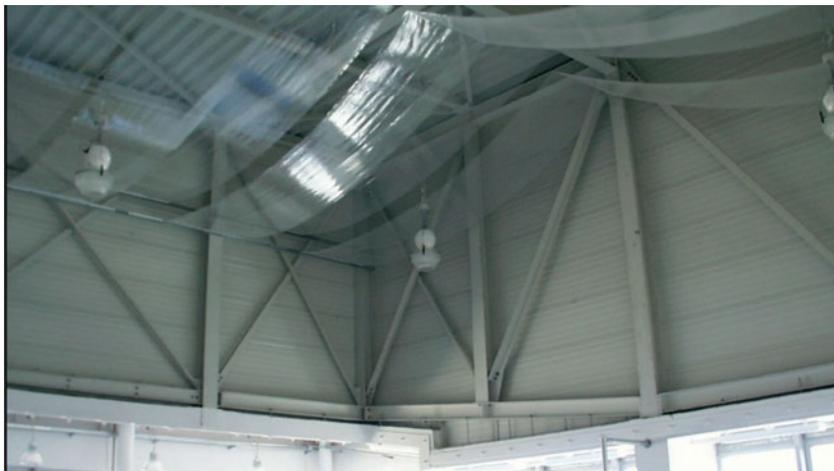
Abbildung 21: Frei abgehängte Bahnen mikroperforierter Folien im Forum des OIC (Office Innovation Center, Fraunhofer Institut) Wack, 2004
